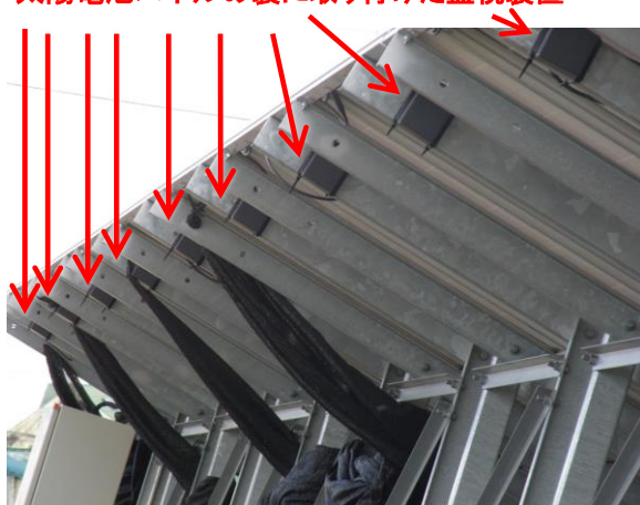
写真 1：太陽光パネルの裏面に取り付けられた IoT 装置により太陽電池 1 枚ごとの状態を監視 左：東光高岳実験場の様子 右：木更津高専実験場の様子
