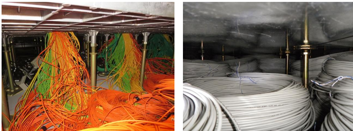
図 4-25 空流を阻害する床下配線の例
